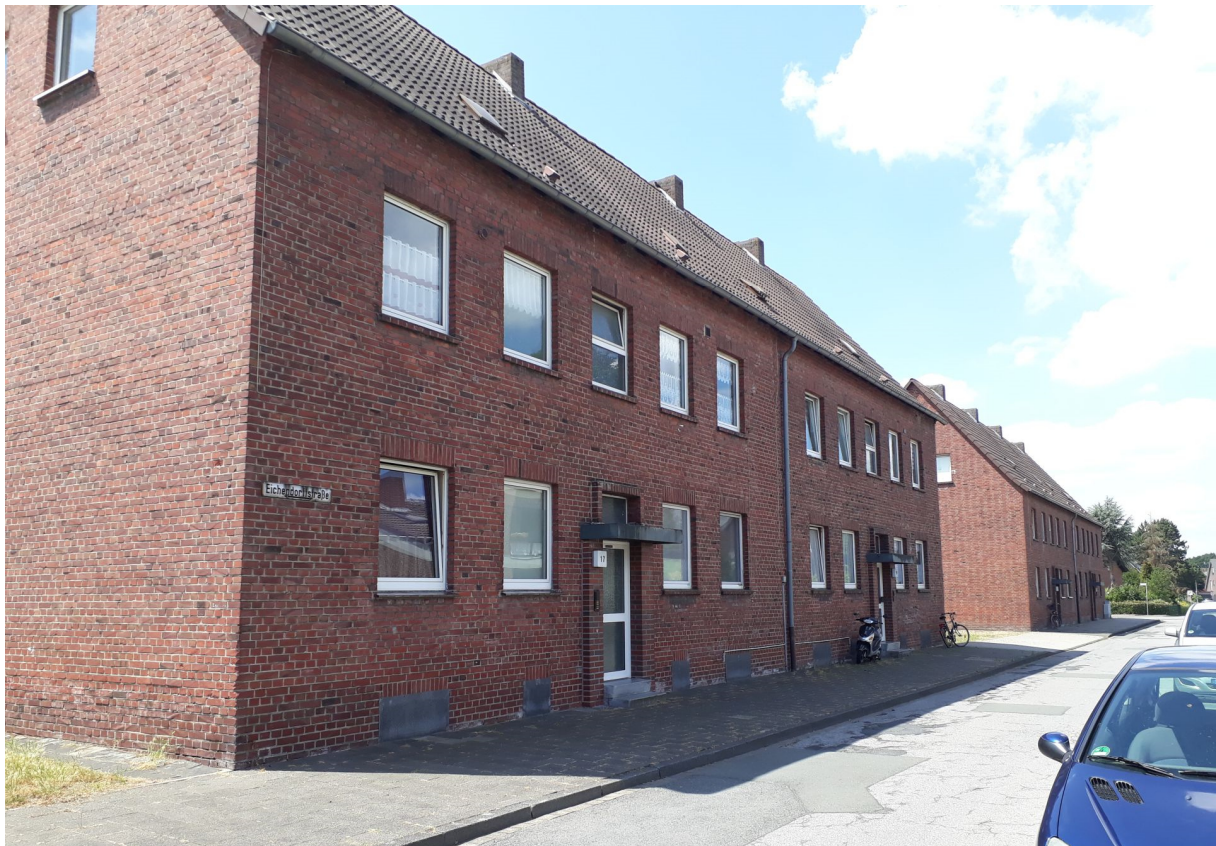
Abbildung 1: Die alten Häuserblocks vor dem Abbruch (01.07.2019)
