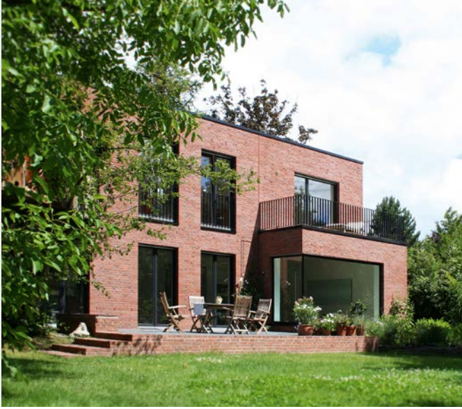
◀ Haus in Münster, Geistviertel Architektur: hehnpohl architektur, DE
