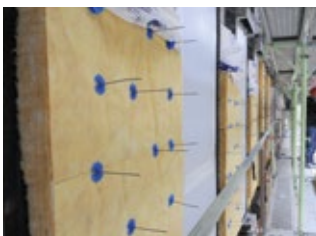
Ausführungsbeispiel: Luftschichtanker
