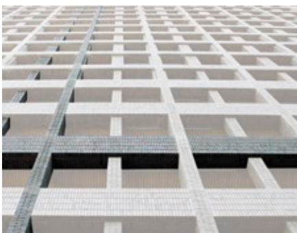
Fassade aus Backsteinfertigteilen
