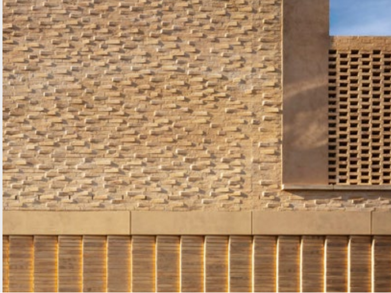
Jüdisches Museum Franken, DE Architektur: umarchitekt, DE
